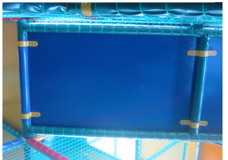
Die Decke und Spielelemente sowie die Deko sind mit Einsenschlaufen verankert. Kein verrutschen
